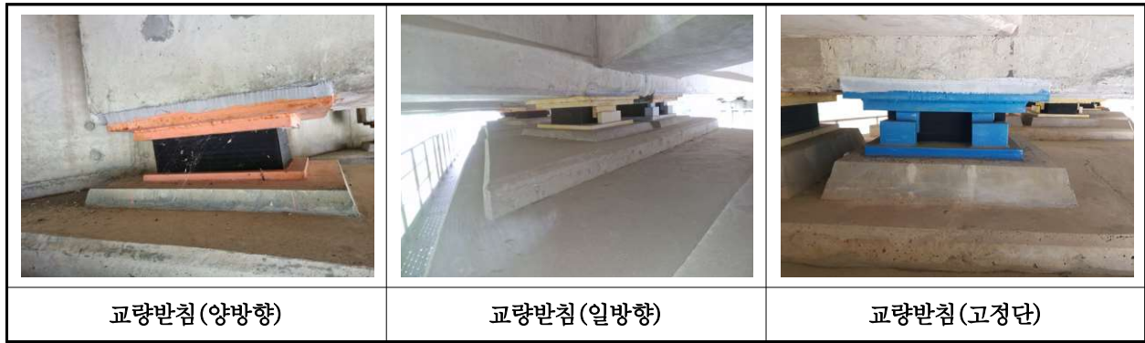
【사진 29.3.13】 교량받침 전경
