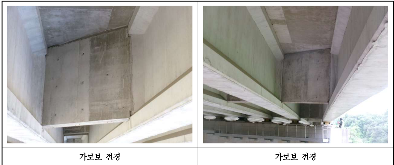
【사진 29.3.6】 가로보 전경
