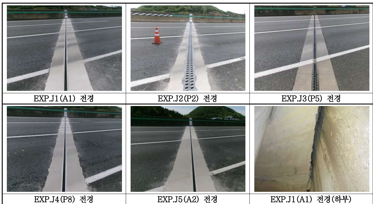
【사진 29.3.17】 신축이음장치 전경
