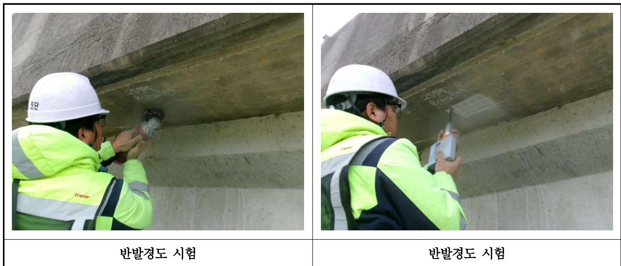
【사진 29.4.2】 반발경도시험 현장사진
