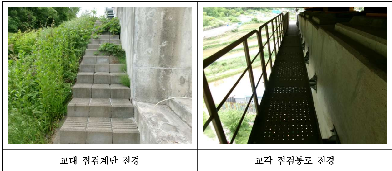
【사진 29.3.26】 교량 점검시설 전경
