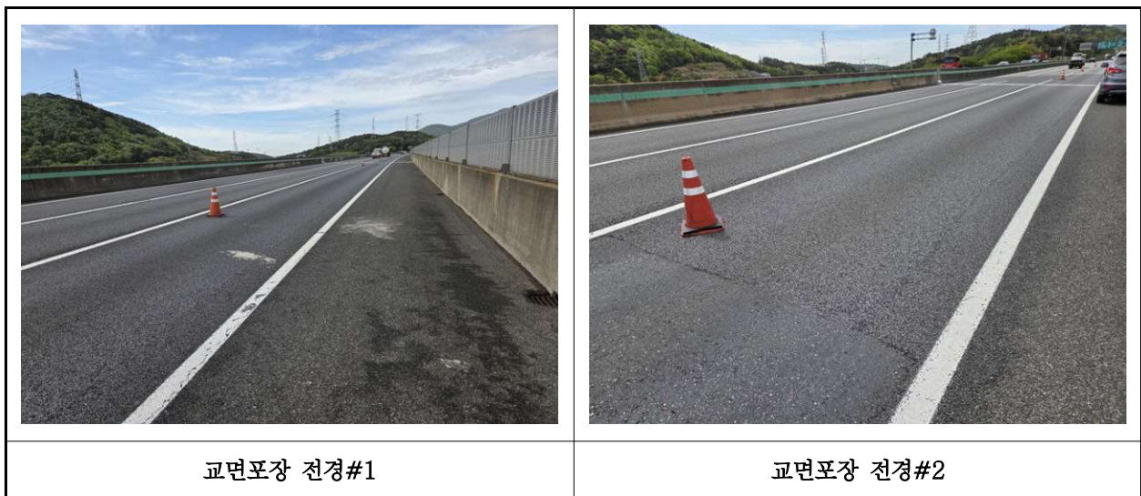
【사진 29.3.20】 교면포장 전경
